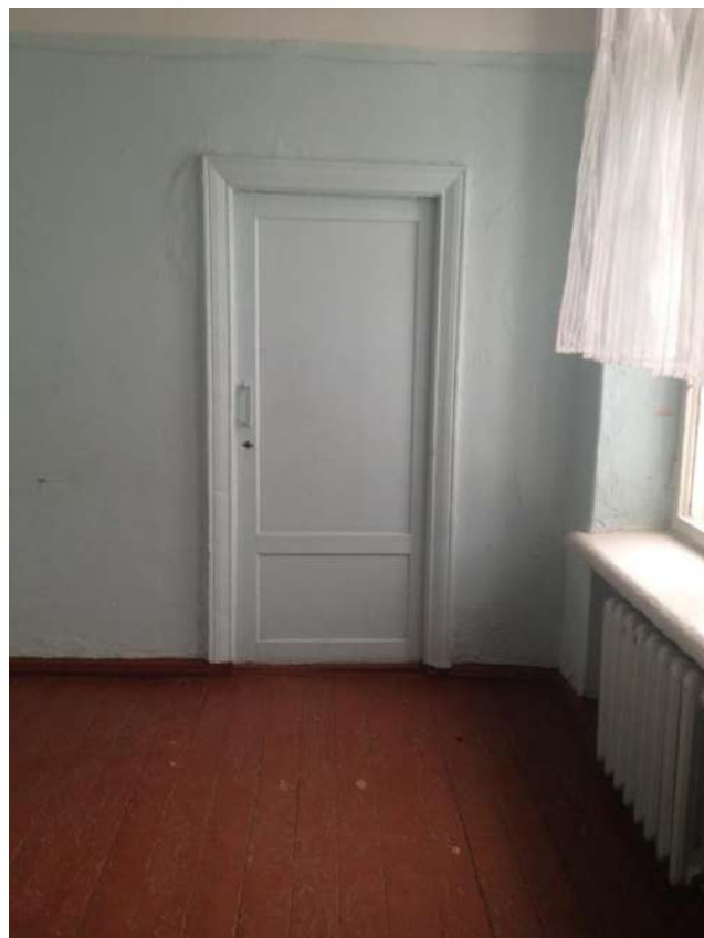
Фото 10 Дверь внутри здания
