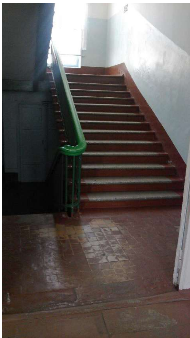
Фото 9 Лестница внутри здания
