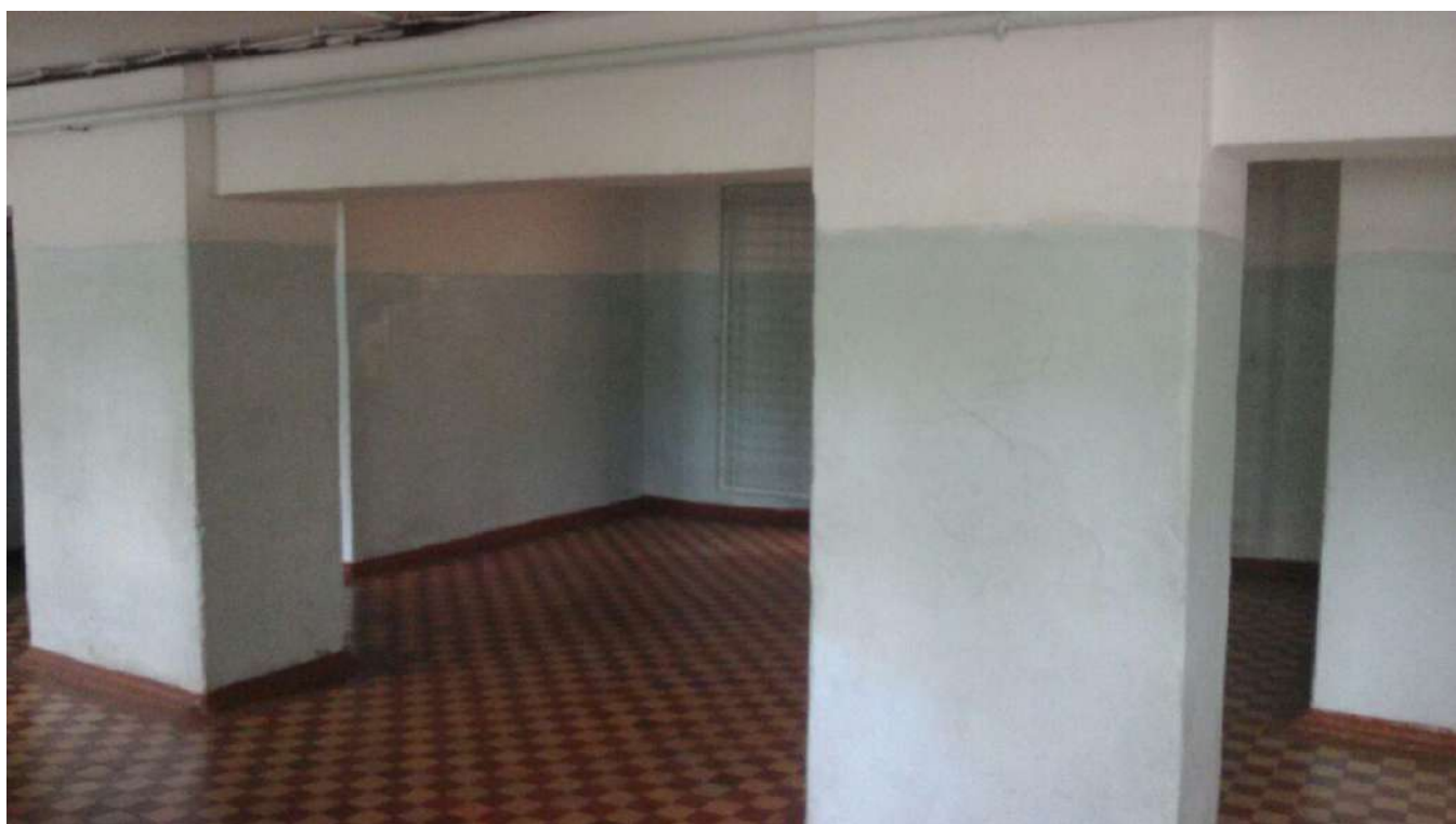
Фото 7 Вестибюль цокольного этажа (подвал)
