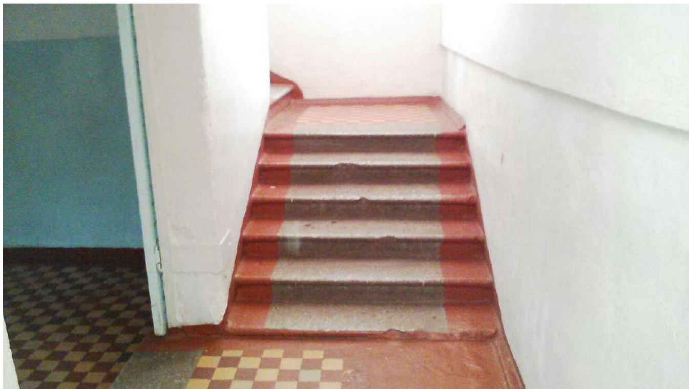
Фото 8 Лестница внутри здания
