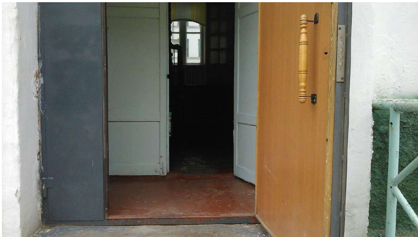
Фото 5 Тамбур эвакуационного входа
